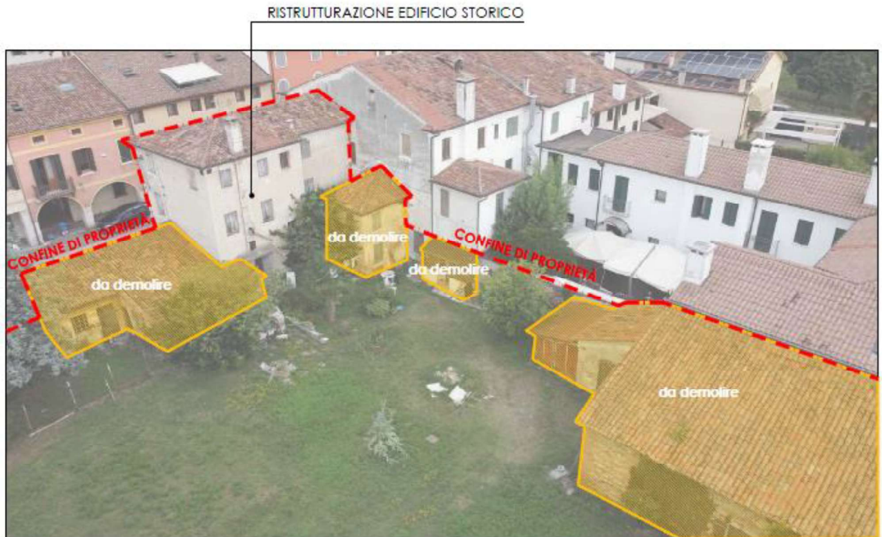
Edifici esistenti oggetto di demolizione
